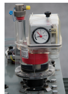
Рис. В18б. Реле защиты трансформатора DGPT
