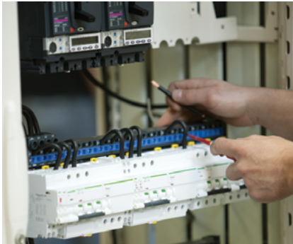
Рис. E30. Конечное РУ со стационарными функциональными блоками (Prisma G)
