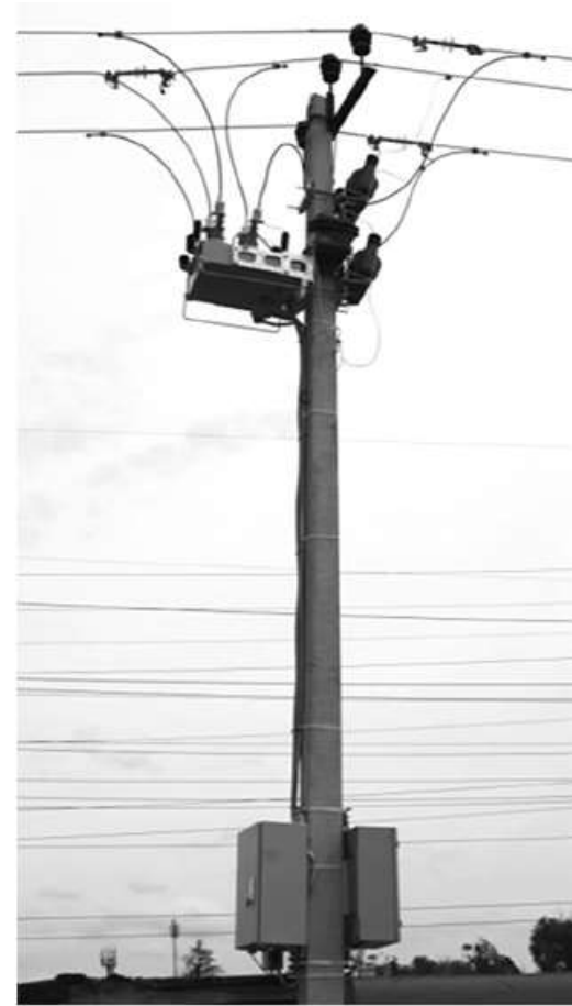
Реклоузеры Rec15_R5 (для установки на отпайках)
