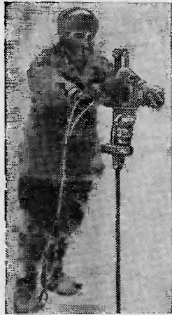
Рис. 24. Погружение вертикальных стержневых электродов ввертыванием с помощью приспособления ПЗ-12.
